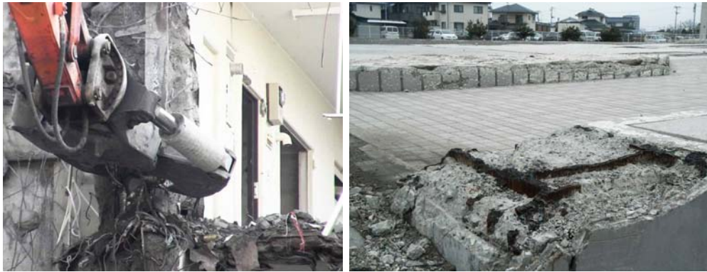
解体作業（左：進行中、右：終了後）
