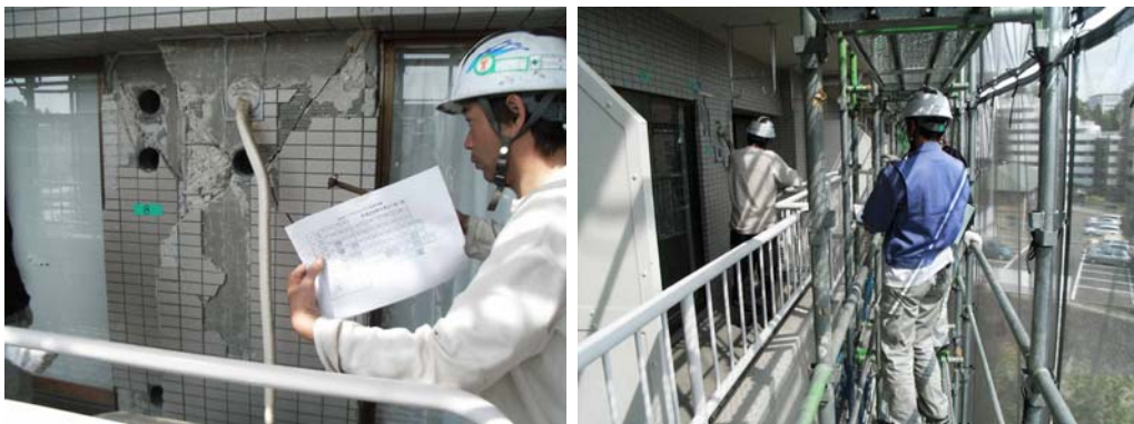
復旧工事（バルコニー側の非耐震壁補修方法の確認）
