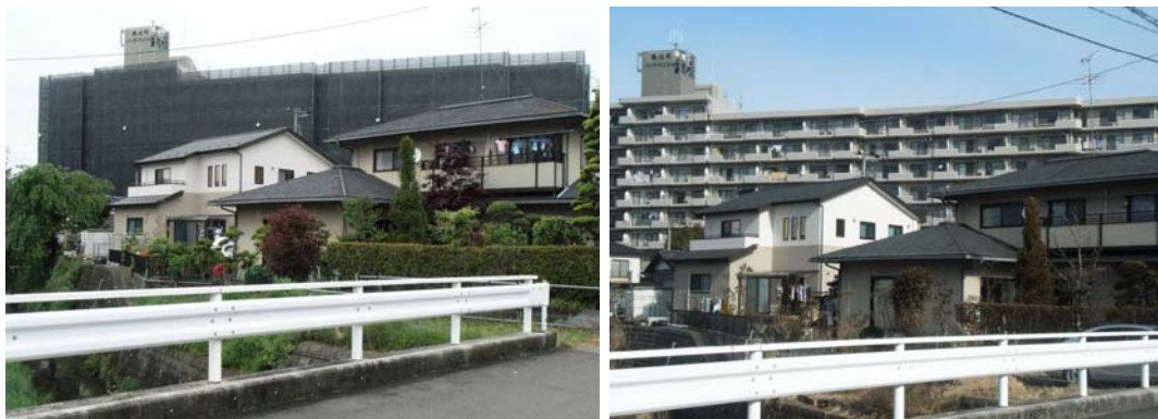
復旧工事（左：進行中、右：終了後）
