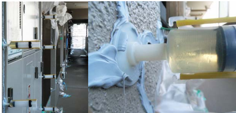
復旧工事（共用廊下側の非耐震壁亀裂部へのエポキシ注入）
