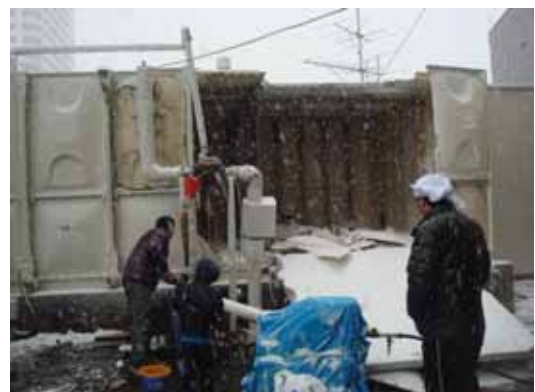
FRP製のユニット型受水槽が地震で大破している。
