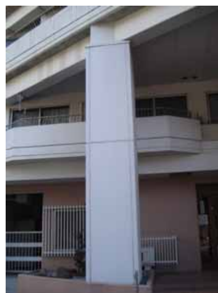
柱に鉄板が巻かれ耐震補強したマンション まったく地震の被害は受けていない
